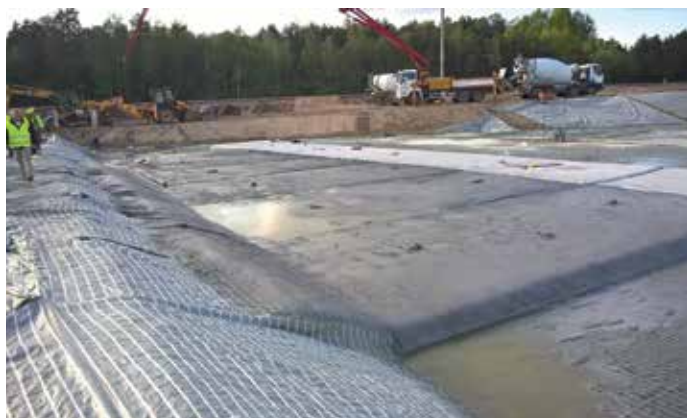
Fot.3 Panele Incomat® Standard w trakcie wypełniania mieszkanką betonową
