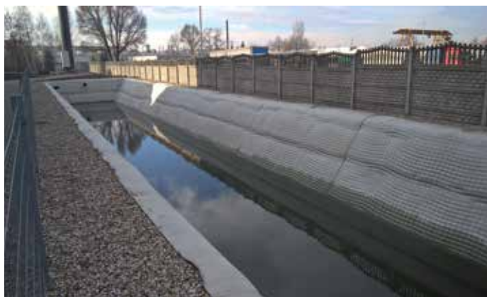
Fot.4 Zbiornik na wody opadowe przy hali produkcyjnej, zabezpieczony materacami Incomat® Standard – pochylenie skarp 56°
