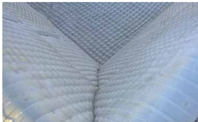
Fot.5 Wygląd powierzchni (naroża) zbiornika na wody opadowe, zabezpieczony materacami Incomat® Standard
