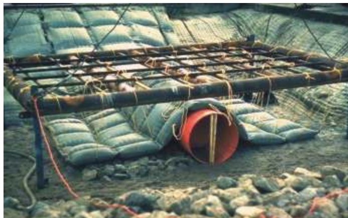
Zabezpieczenie rurociągu kompozytem Incomat® Flex.
