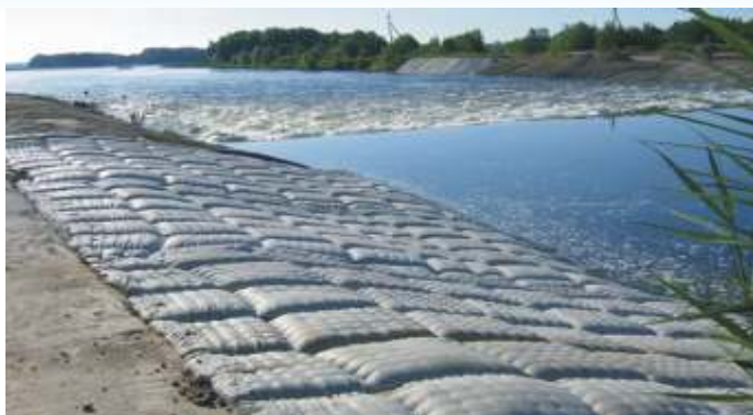
Incomat® Flex po wypełnieniu betonem.
