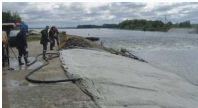
Incomat® Flex wypełniany betonem.
